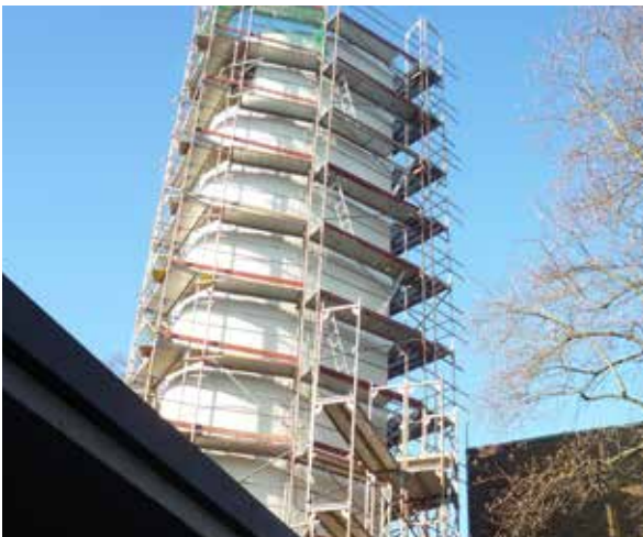
Beginn der Gerüstarbeiten Einrüstung des Glockenturms
