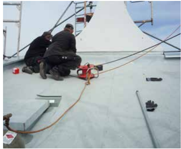
Die Dachdeckerarbeiten beginnen!
