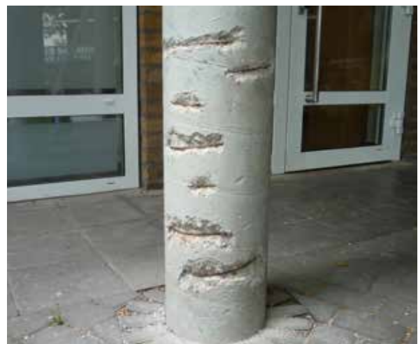
Zum Schluss: Die Sanierung der Säulen
