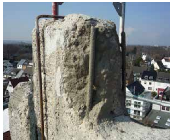
Die Turmluke auf der Wetterseite musste komplett erneuert werden
